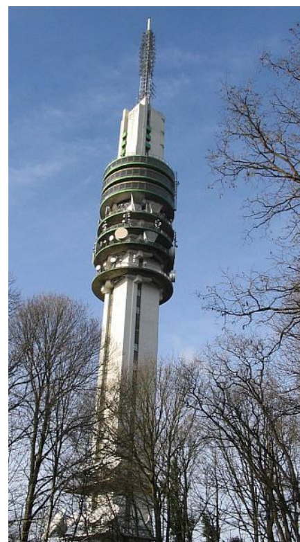
Tv-toren Hilversum, belangrijke schakel in het interknooppuntverkeer van ASCON tussen Oegstgeest en Wezep
