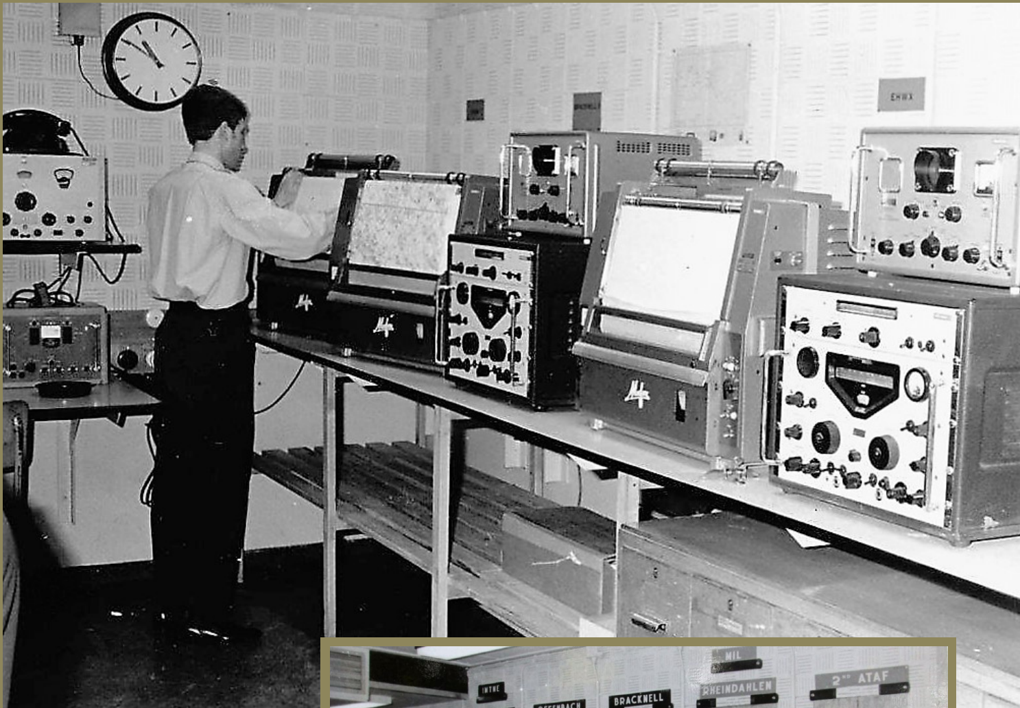
Luchtmacht Meteo Centrum in Hilversum na de ingrijpende verbouwing van de Rossini-bunker. Racal ontvangers en Mufax facsimile apparatuur voor het overbrengen van weerkaarten vormen belangrijke communicatiemiddelen voor de meteorologische dienst in die tijd (foto: historisch archief JMG)
