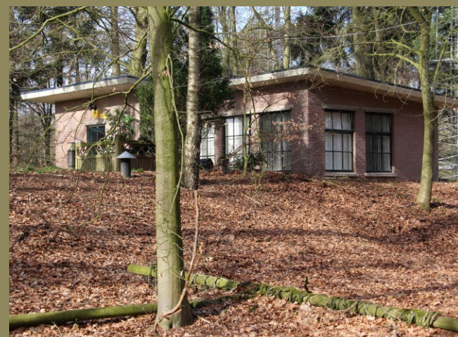
Karakteristieke bovenbouw met ingang naar de TRC-bunker anno 2017 (foto: kap b.d. A.J.J. Buitendam)
