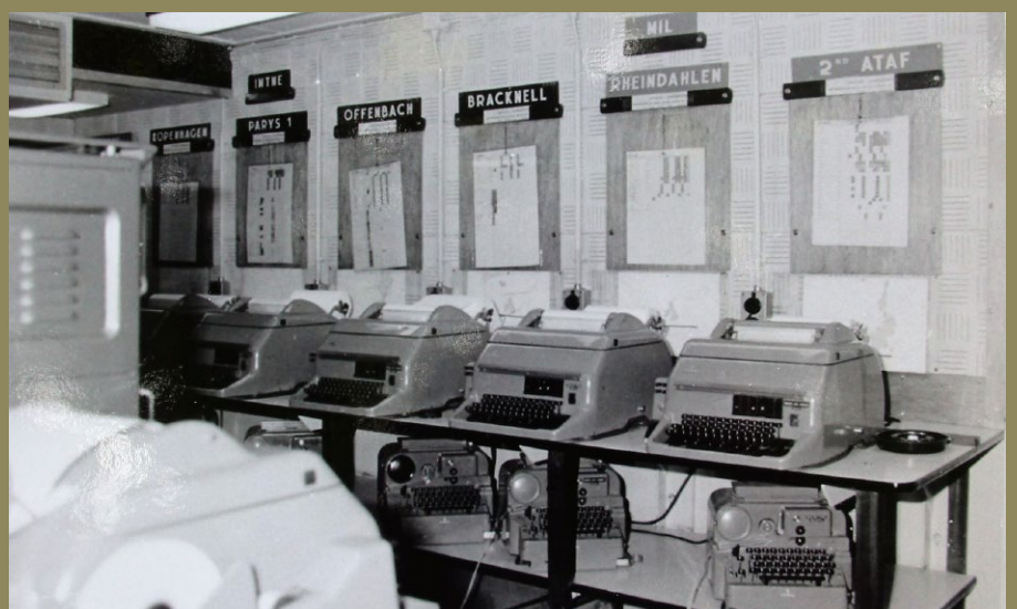
Luchtmacht Meteo Centrum Hilversum in de jaren zestig. Siemens T100 bladschrijver en Siemens T68 schrijponsonvanger, de ultieme telexapparatuur op de internationale meteo-verbindingen in die jaren (foto: historisch archief JMG)
